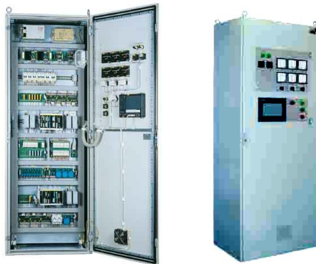
Рисунок 1.13 – Автоматический регулятор ЭГР-МП
